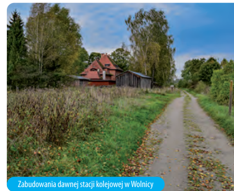
Zabudowania dawnej stacji kolejowej w Wolnicy
