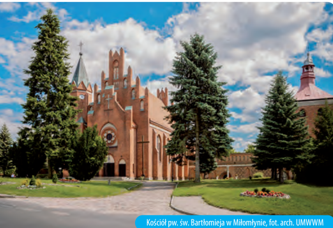
Kościół pw. św. Bartłomieja w Miłomłynie, fot. arch. UMWWM
