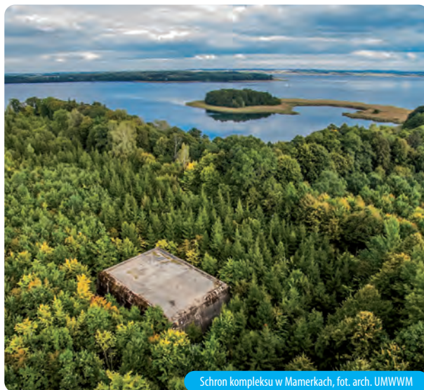
Schron kompleksu w Mamerkach, fot. arch. UMWWM
